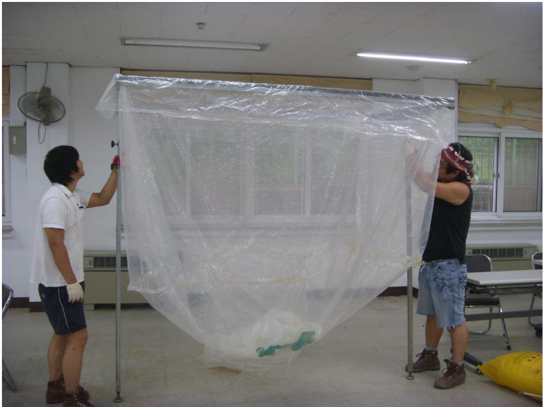
석면해체를 위해 컨테이너해체 장치를 설치
