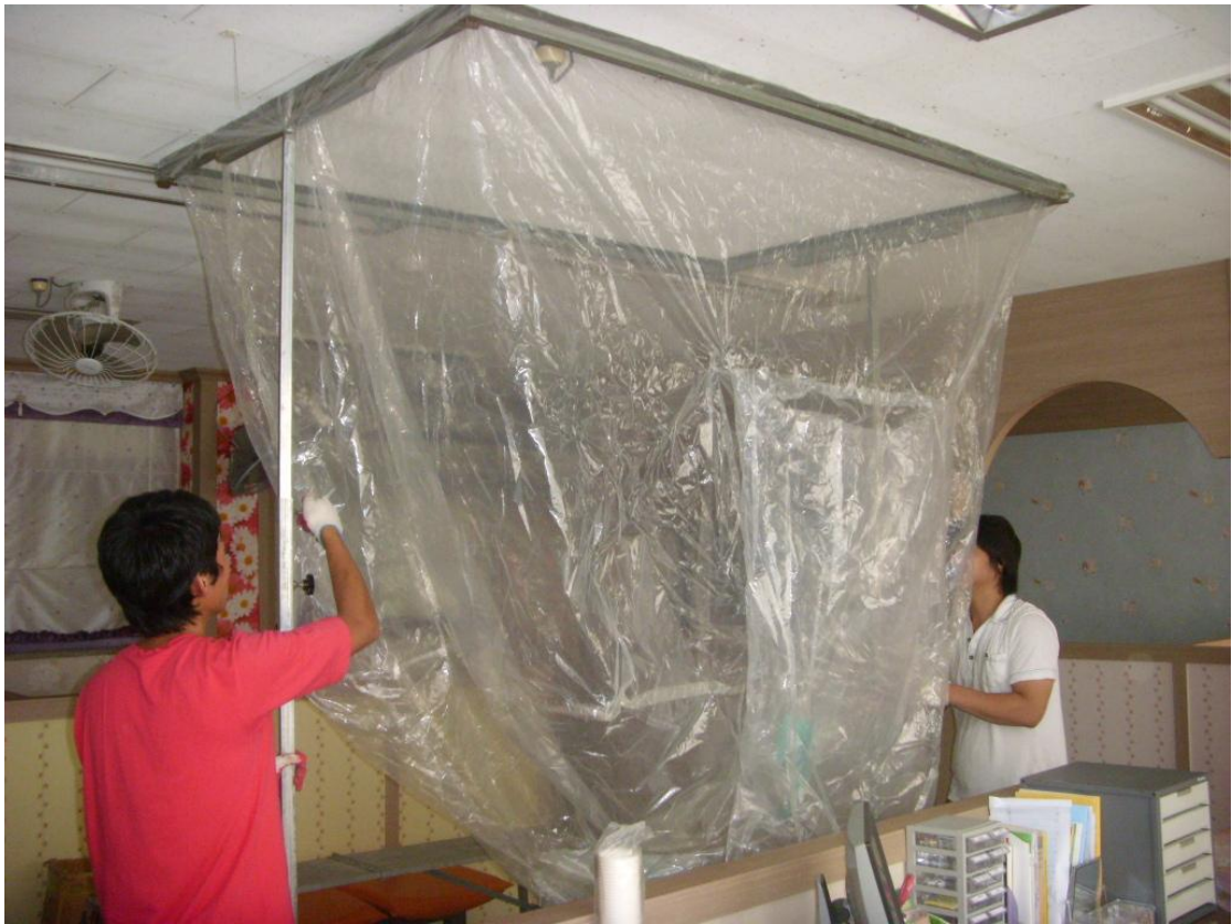
석면해체를 위해 비닐수지부착형 해체장치를 설치(천정에 고정)
