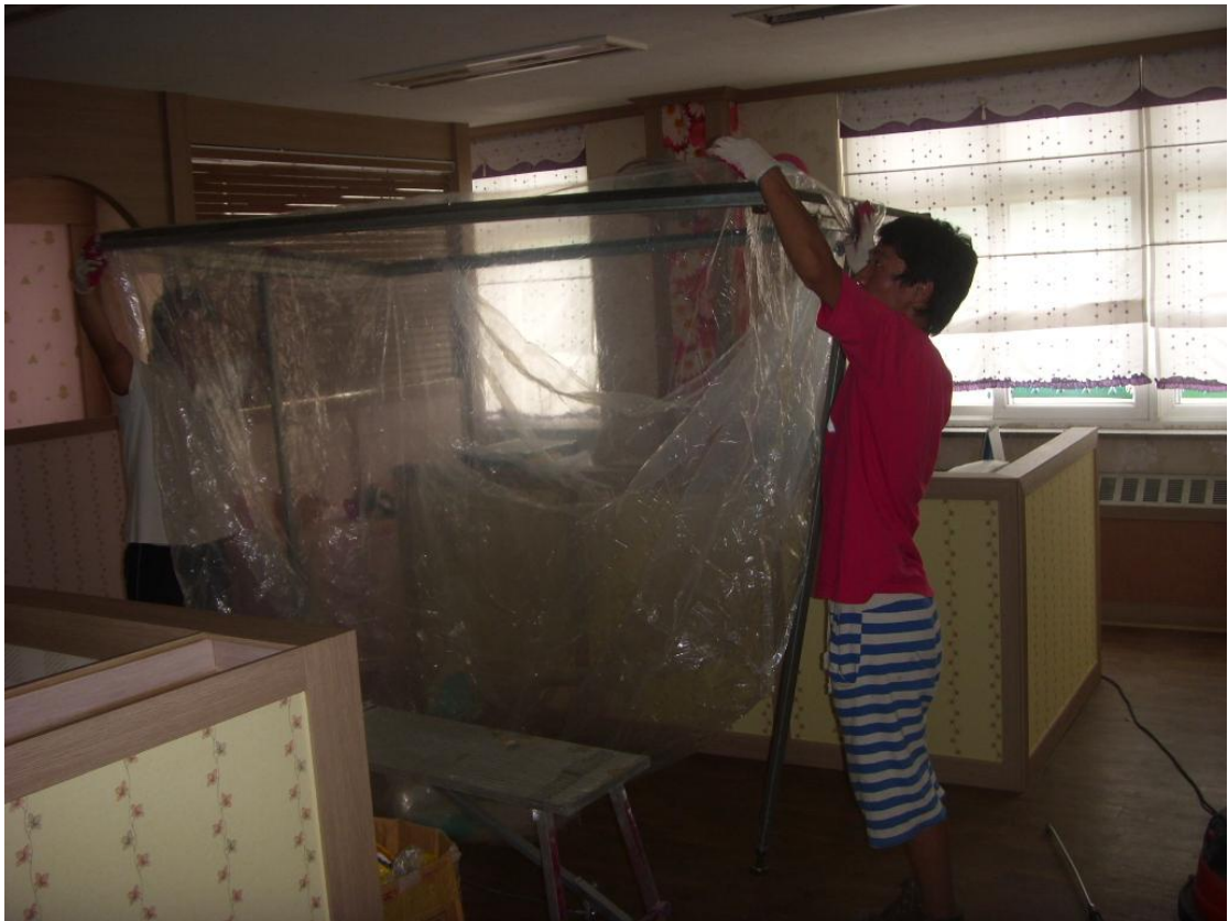
석면해체를 위해 컨테이너해체 장치를 설치
