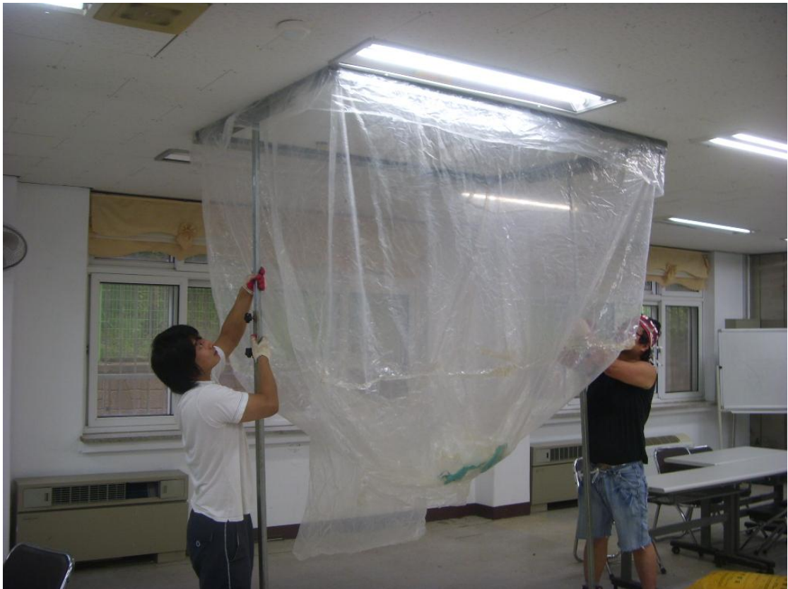
석면해체를 위해 컨테이너해체 장치를 설치(천정에 고정)
